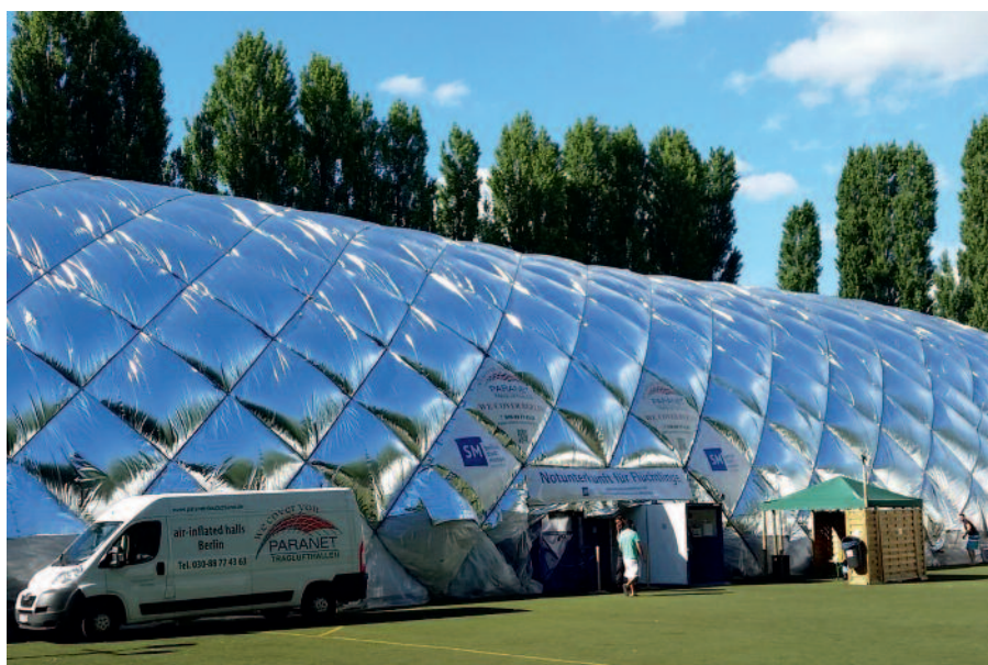
Eine vergleichbare Traglufthalle wurde durch die Firma Paranet in Taufkirchen bei München aufgebaut. Die neuartige winter- und wetterfeste Unterkunft für Asylbewerber hat bei optimaler Raumaufteilung Platz für bis zu 300 Menschen.
